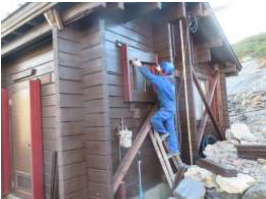
5 撮影日 10月9日(火) 備考 冬期フード設置作業
